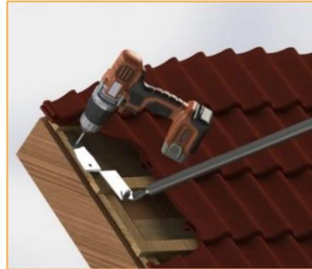
2. Schelle unmittelbar am Elementstoß positionieren. Gestänge dabei in einem Winkel von ca. 60°±5° zur Dachfläche abspannen
