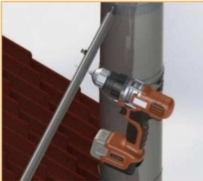
5. Die Teleskopstangen werden kraftschlüssig verbunden (verschrauben). Alternativ kann eine stoffschlüssige Verbindung durch Verschweißen hergestellt werden.
