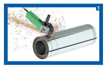
Gewünschte Länge am Außenrohr antragen und mit einem Winkelschleifer das Außenrohr durchtrennen.
