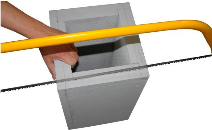
Schachtelement aufstellen und senkrecht an die Markierung bis zu einer Tiefe von 1/2 Schachtwandungsstärke einschneiden
